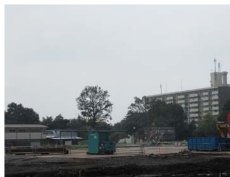
現在工事中です
